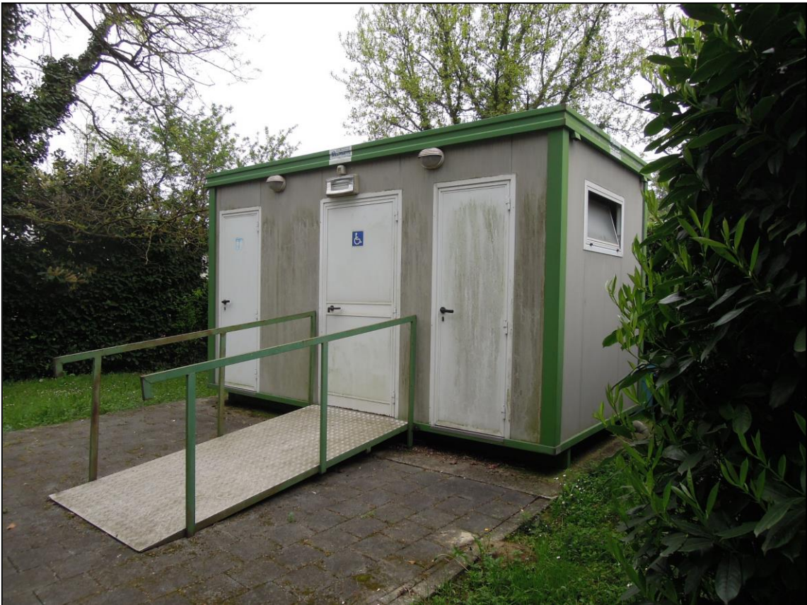
11-12- Interno – Bagni esterni
