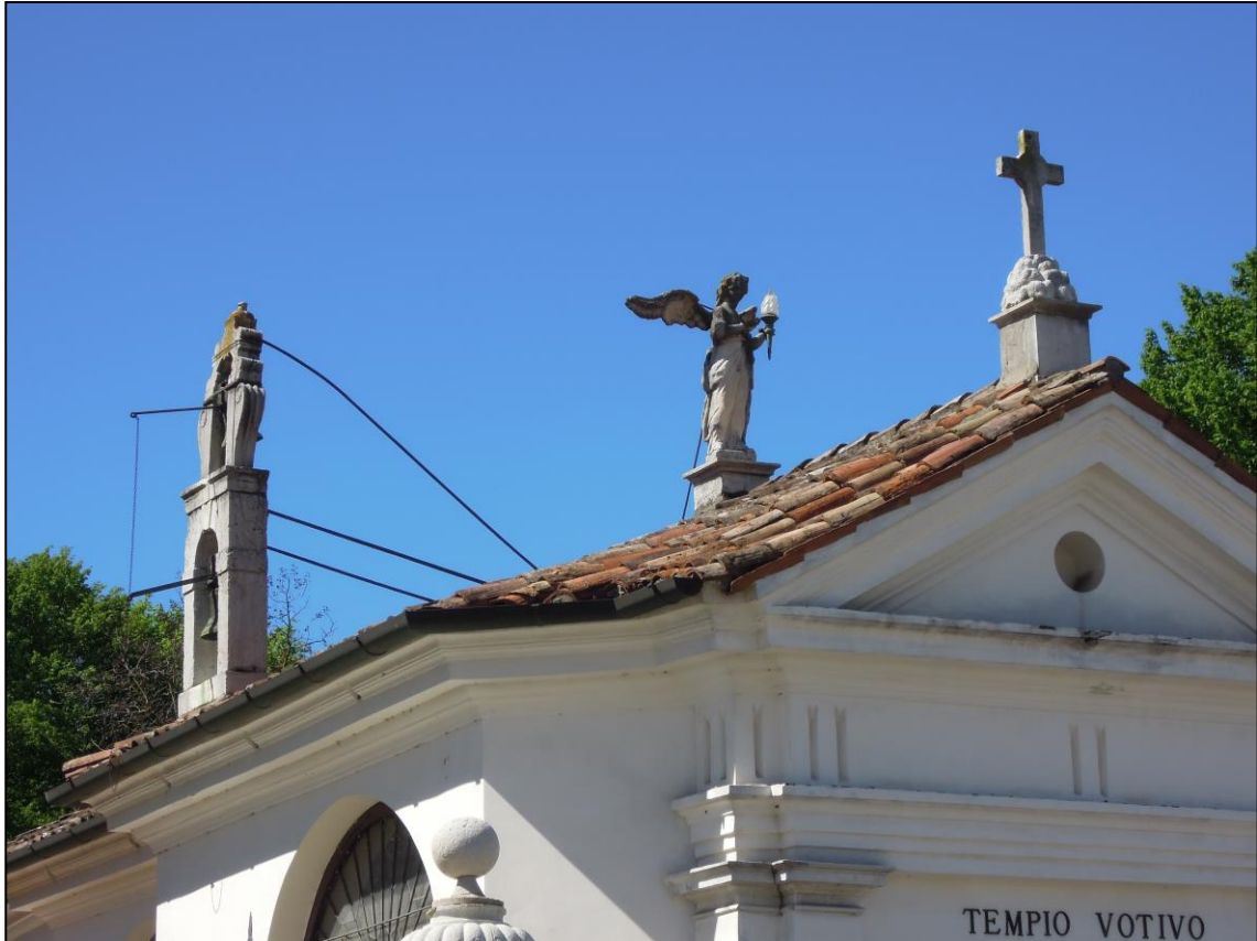
1-2- Facciata e dettaglio copertura
