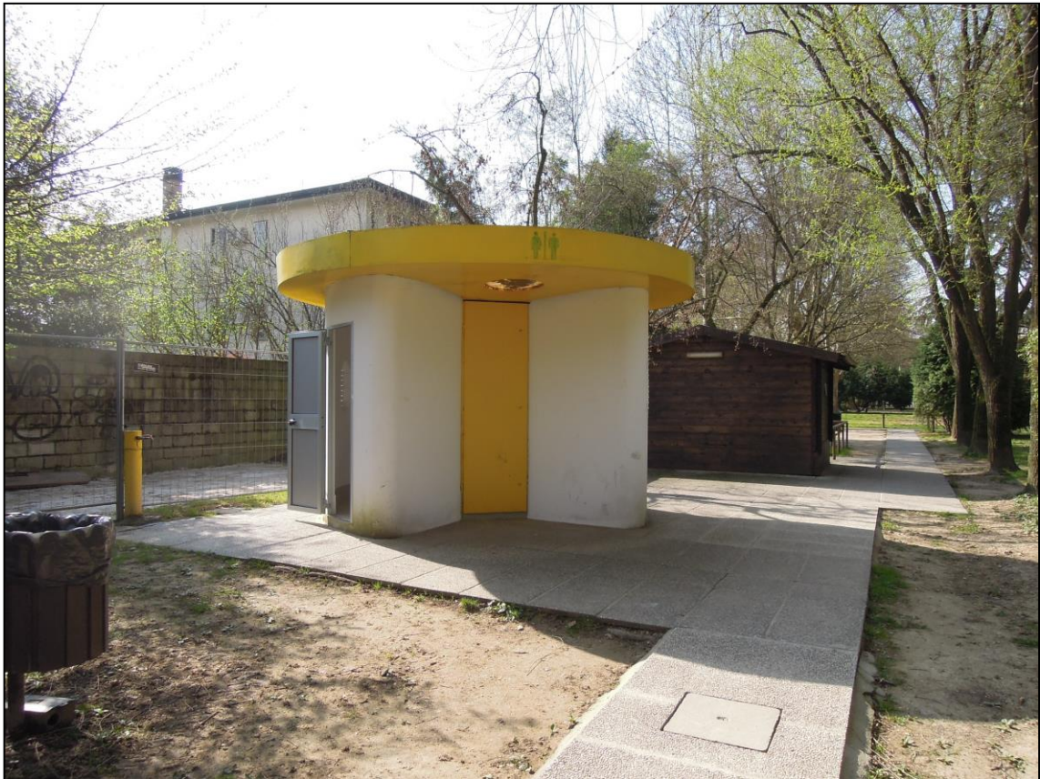
5-6- Quadro elettrico dietro al palco e servizi igienici
